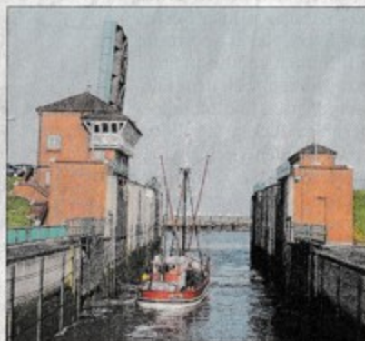
Ein Schiff passiert die Schleuse Leysiel. Sie ist Teil eines der größten Küstenschutzprojekte Niedersachsens. Dessen Abschluss fiel in Wiltfangs Amtszeit. Foto: Karin Spengler/Archiv
